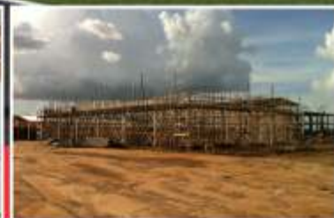
Obras em andamento
