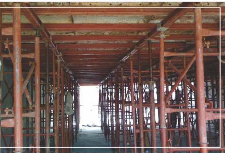
O escoramento metálico de lajes é visto com muito bons olhos pelos órgãos ambientais: menos madeira no processo
